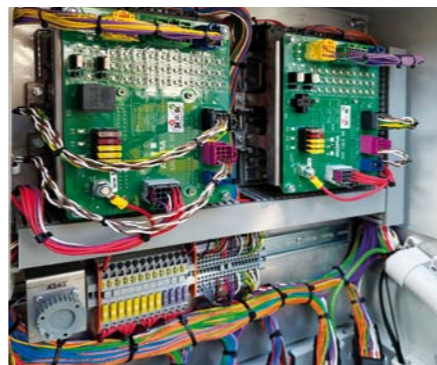
Přehledné elektrické zapojení, s popisky jednotlivých vodičů po celé délce kabelu. Všechny pojistky s LED kontrolkou
